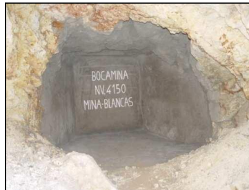
Imagen 4. Sellado de bocamina con método hermético.
