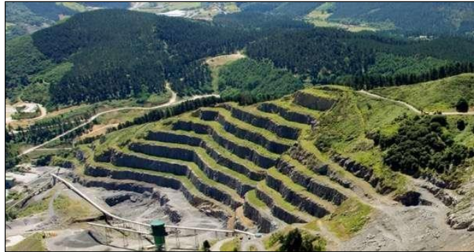
Imagen 7. Banqueo, cobertura y revegetación de cantera.
