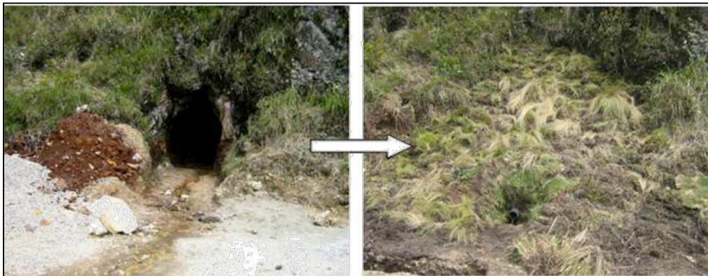
Imagen 6. Sellado de bocamina con acumulación de desmonte
