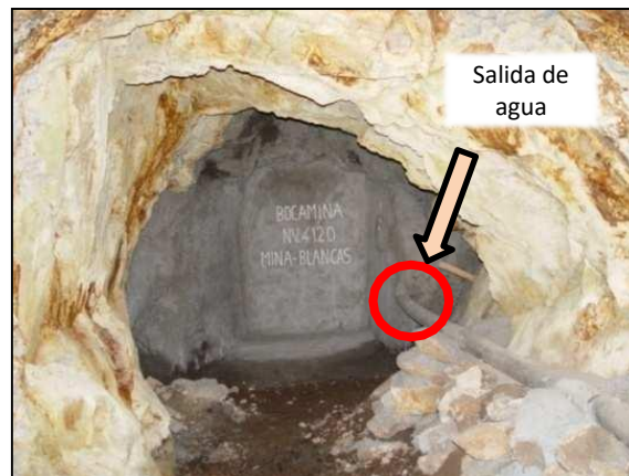
Imagen 5. Sellado de bocamina con método de bloque de aire.
