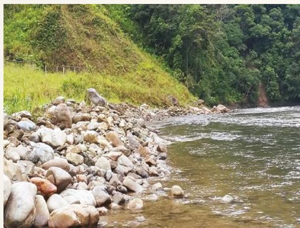
Presencia de un muro de enrocado cuyo fin es restaurar el cauce hídrico natural del río Tutupali
