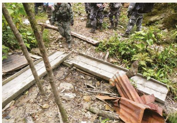
Canalones que conducen el agua resultante de los procesos mineros
