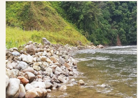
Presencia de un muro de enrocado cuyo fin es restaurar el cauce hídrico natural del río Tutupali
